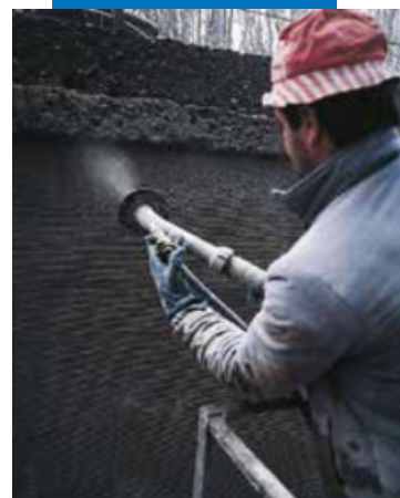
Механизированное нанесение методом мокрого торкретирования
