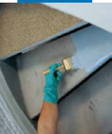
Нанесение первого слоя Марескоат I 24 на бетон
