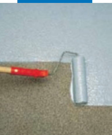
Нанесение Марескоат I 24 валиком
