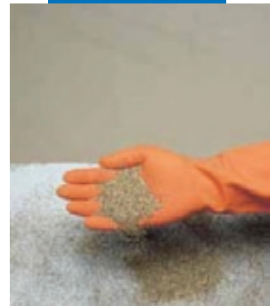
Обсыпка сухим песком по свежему Marecoat I 24
