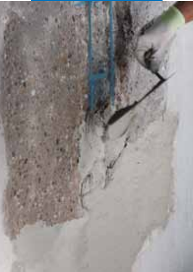
Нанесение Планитопа Ремонт & Финиш мастерком
