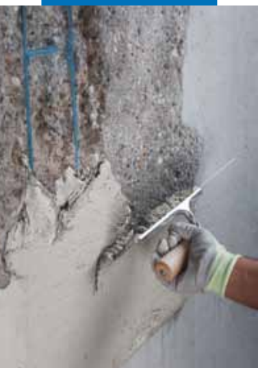
Нанесение Планитопа Ремонт & Финиш шпателем
