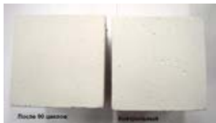
Фото 1. Общий вид лицевой поверхности образцов до испытаний и после 90 циклов ускоренных климатических испытаний (покрытие Elastocolor Paint). Трещин, пузырей, отслоений не наблюдается. Отмечается незначительное изменение декоративных свойств — (посветление покрытия); пятен, меления и других дефектов не отмечается.
