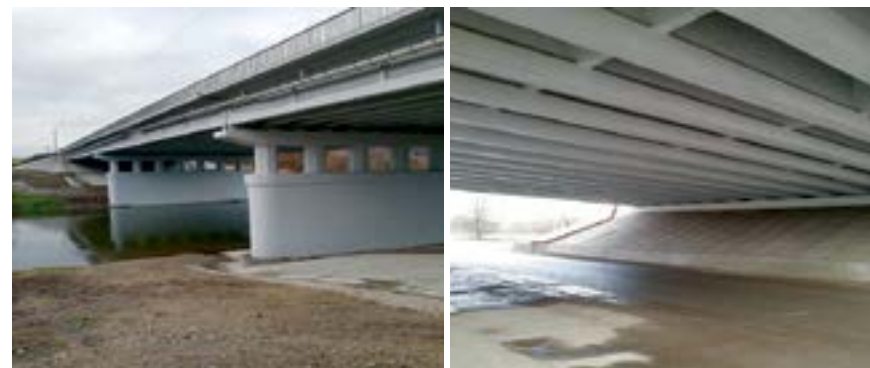
Рисунок 5.6. Путепровод на Домодедовском шоссе, 37-й км. Материалы: Mapegrout Thixotropic, Monofinish, Elastocolor Paint.
