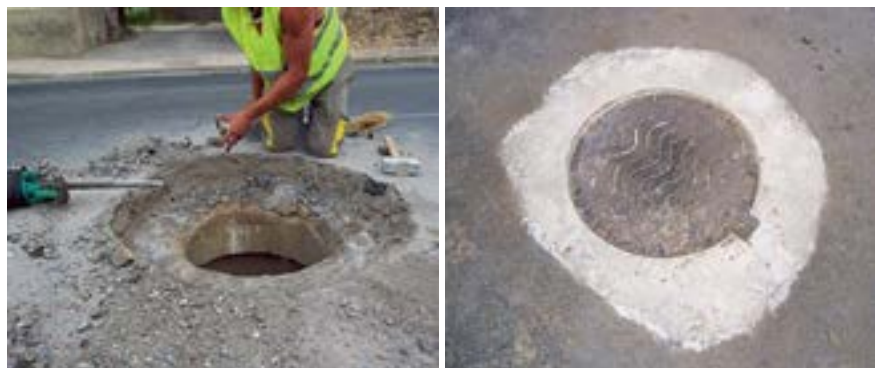
Рисунок 5.3. Омоноличивание люков проезжей части в период предоставления ремонтного окна. Материалы: Mapegrout SV-R Fiber.
