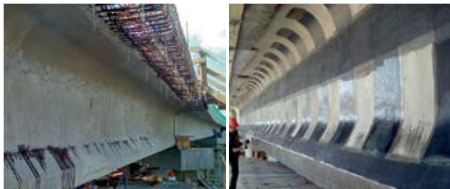
Рисунок 5.4. Путепровод через автомобильную дорогу М-5 «Урал», 104-й км. Материалы: Mapegrout Fast Set R4, Epojet, MapeWrap C UNI AX, MapeWrap 31, MapeWrap Primer.
