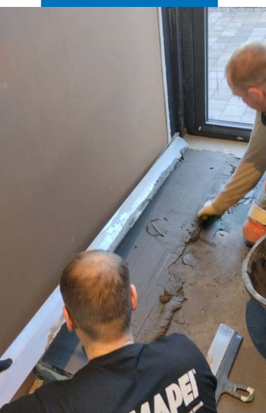
Ремонт и выравнивание входной зоны
