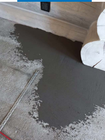
Выравнивание перепадов с выведением «В ноль»
