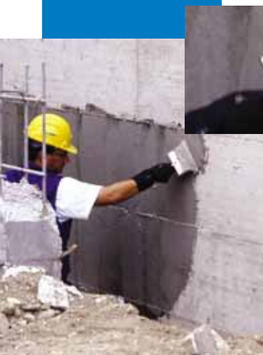
Пример гидроизоляции фундамента с помощью кисти
