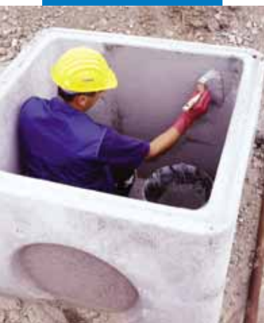
Пример гидроизоляции шахты люка с помощью кисти
