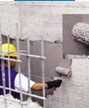
Пример гидроизоляции фундамента с помощью валика
